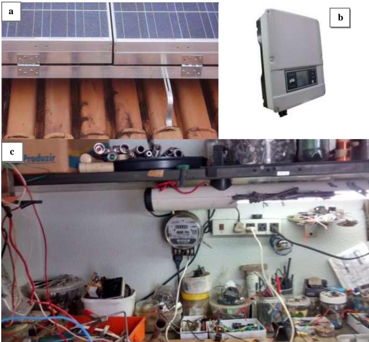
Figura 3: Módulos fotovoltaicos fixo no telhado da residência, com a ajuda de dobradiças (a). Inversor central grid tie (b). Medidor de geração de energia elétrica do painéis solares (relógio) (c).
